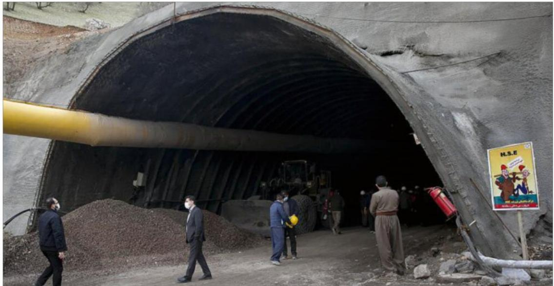
وی با اشاره به اینکه کل پروژه تونل ۸۰ درصد پیشرفت فیزیکی دارد: گفت: این تونل با ۱۰۸۰ متر طول، طولانی ترین تونل استان محسوب می‌شود. عرض تونل ۱۱ متر و ۴۰ سانتی متر است که از دو لاین استاندارد برای عبور کامیون ها و پیاده رو کاری برخوردار است.
